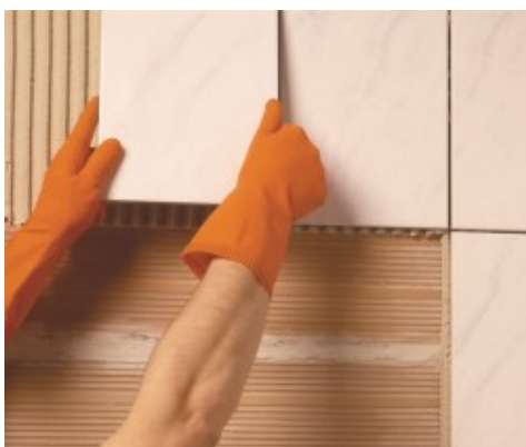
Assentamento do revestimento em parede
