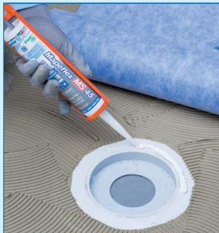
Aplicação de MAPEFLEX MS 45 à volta da descarga
