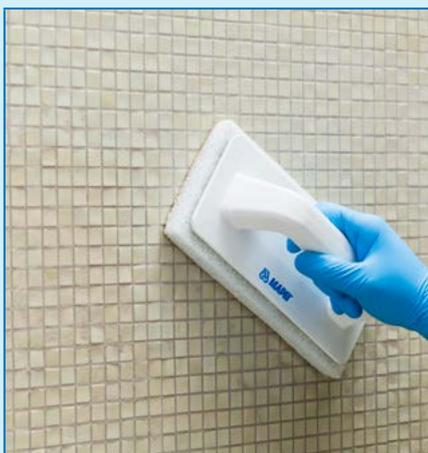
Limpeza da pastilha de vidro com um esfregão abrasivo húmido Scotch-Brite®
