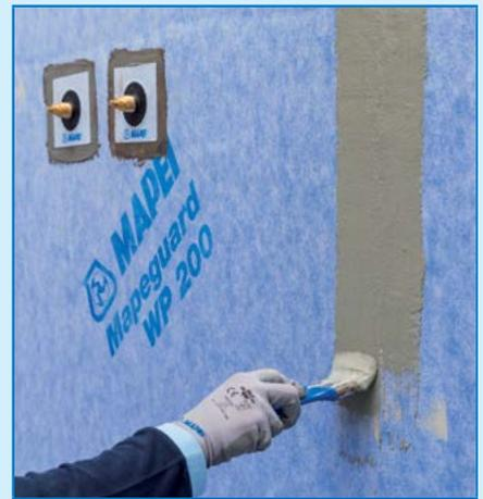
Aplicação de MAPEGUARD WP ADHESIVE antes da aplicação de MAPEGUARD ST para selar a junção entre as duas membranas adjacentes
