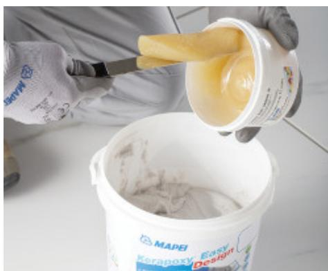
Verter o endurecedor (componente B) no recipiente do componente A
