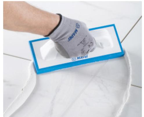
Betumação epóxi de fácil aplicação
