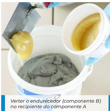
Verter o endurecedor (componente B) no recipiente do componente A
