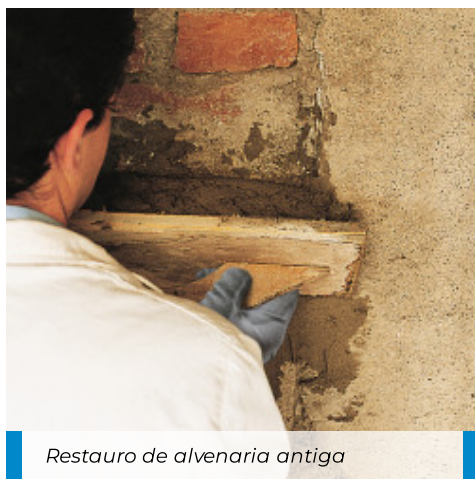
Aplicação de Nivoplan à talocha
