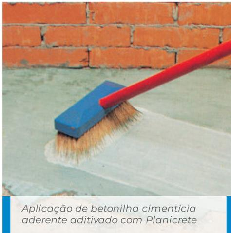
Aplicação de betonilha cimentícia aderente aditivado com Planicrete
