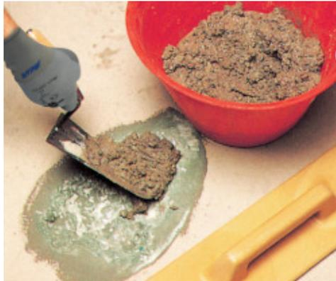
Reparação de pavimento: aplicação de argamassa
