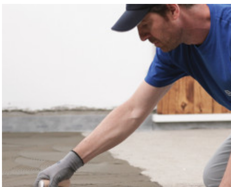
Aplicação do adesivo com espátula dentada n.º 5
