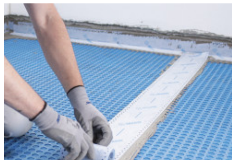
Impermeabilização das junções entre as telas adjacentes com Mapeband Easy colado com Mapeguard WP Adhesive
