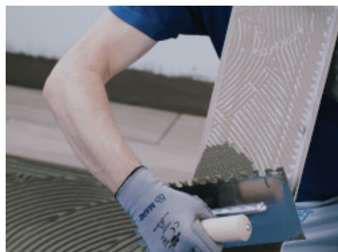
Assentamento do pavimento em cerâmica ou material pétreo com adequado adesivo Mapei de classe não inferior a C2
