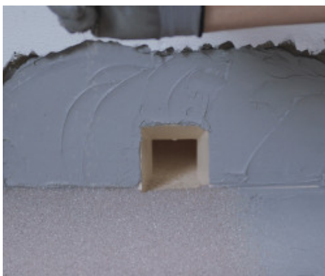
Impermeabilização da descarga com Drain Front
