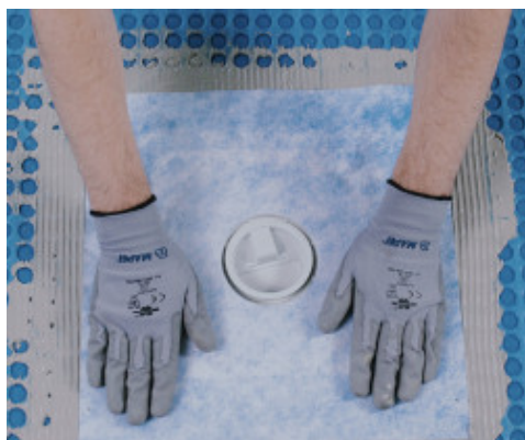
Impermeabilização da descarga com Drain Vertical/ Drain Lateral
