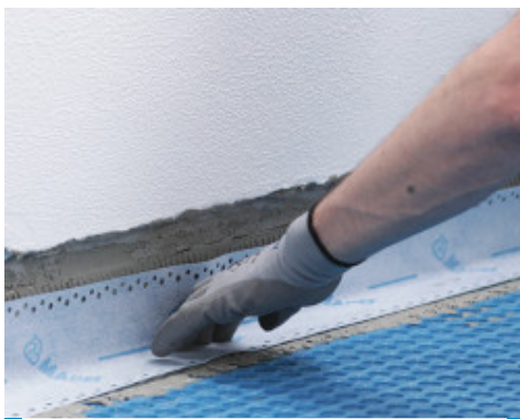
Impermeabilização perimetral com Mapeband Easy colado com Mapeguard WP Adhesive
