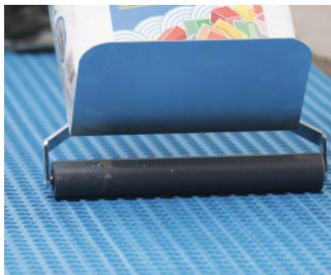
Pressionamento de Mapeguard UM 35
