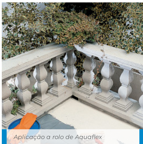
Aplicação do Aquaflex por pulverização sobre cimento-amianto ondulado tratado com Malech
