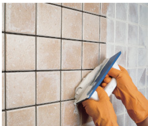
Execução de juntas de revestimento em monocozedura com espátula
