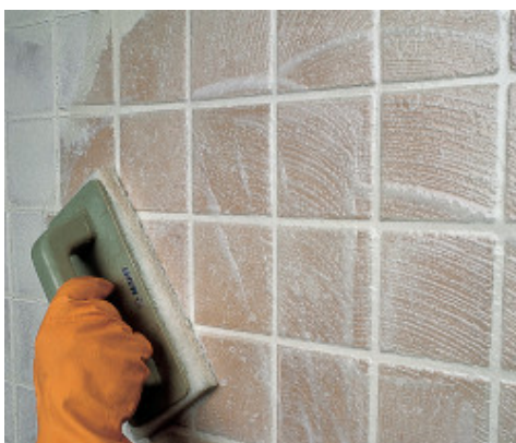
Acabamento de ladrilhos de monocozedura com Scotch-Brite
