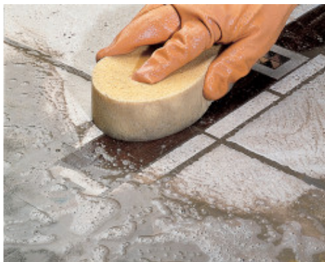
Acabamento de pavimento cerâmico com inserções em madeira com esponja
