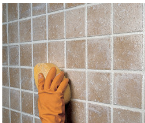
Acabamento de revestimento em monocozedura com esponja
