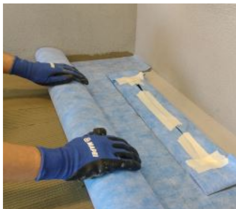
Aplicação de Mapeguard WP 200
