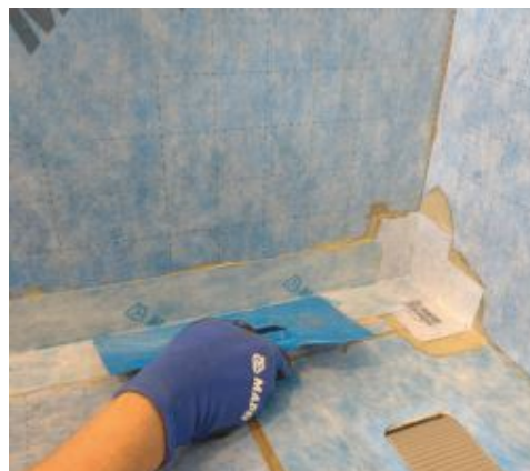
Aplicação de Mapeguard ST
