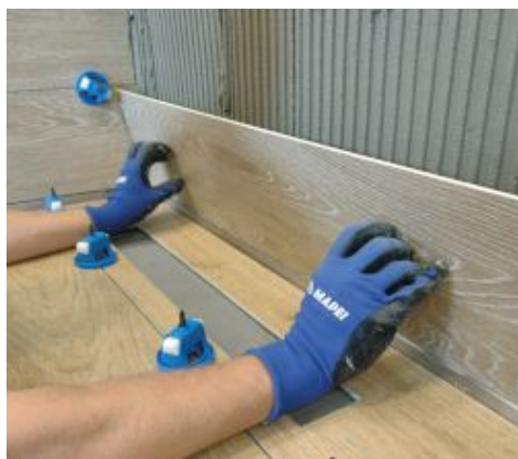
Aplicação dos ladrilhos
