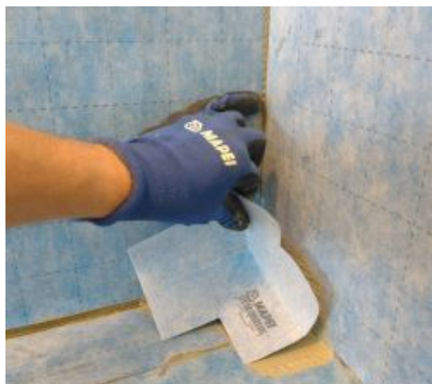
Aplicação de Mapeguard IC
