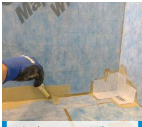
Aplicação de Mapeguard WP Adhesive
