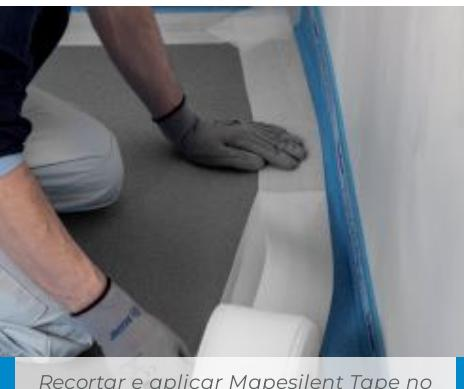
Recortar e aplicar Mapesilent Tape no canto e em todas as ligações e sobreposições de modo a garantir a perfeita proteção das juntas
