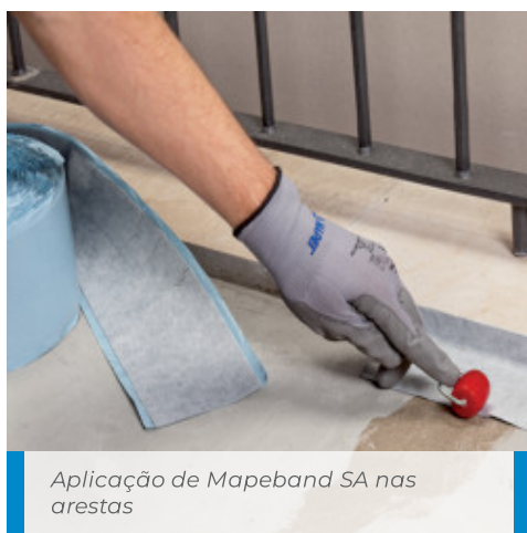
Aplicação de Mapeband SA sobre betonilha
