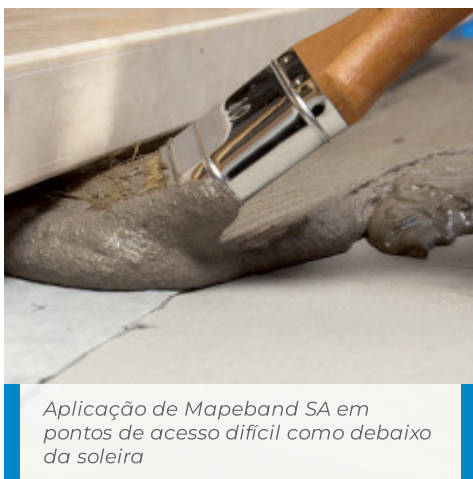
Aplicação de Mapeband SA nos cantos
