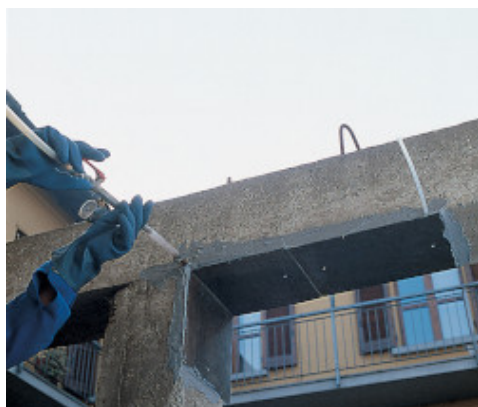
Placagem de traves mediante injeção de Epojet
