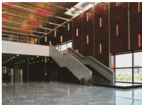
Exemplo de assentamento de pavimento em mármore com Keraquick S1 - Hall do Casino Feuchtwangen (Alemanha)
