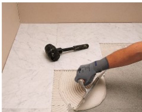
Assentamento de mármore de Carrara branco com Keraquick S1 branco
