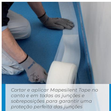
*Cortar e aplicar Mapesilent Tape no canto e em todas as junções e sobreposições para garantir uma proteção perfeita das junções*
