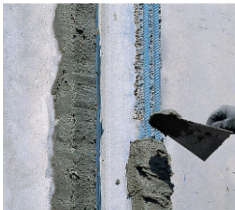
Aplicação com colher de pedreiro
