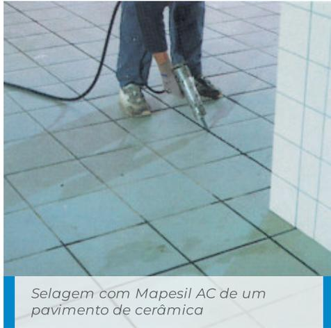
Selagem com Mapesil AC de um pavimento de cerâmica
