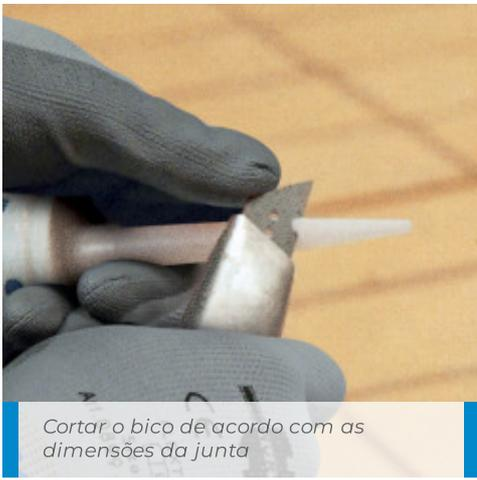
Cortar o bico de acordo com as dimensões da junta
